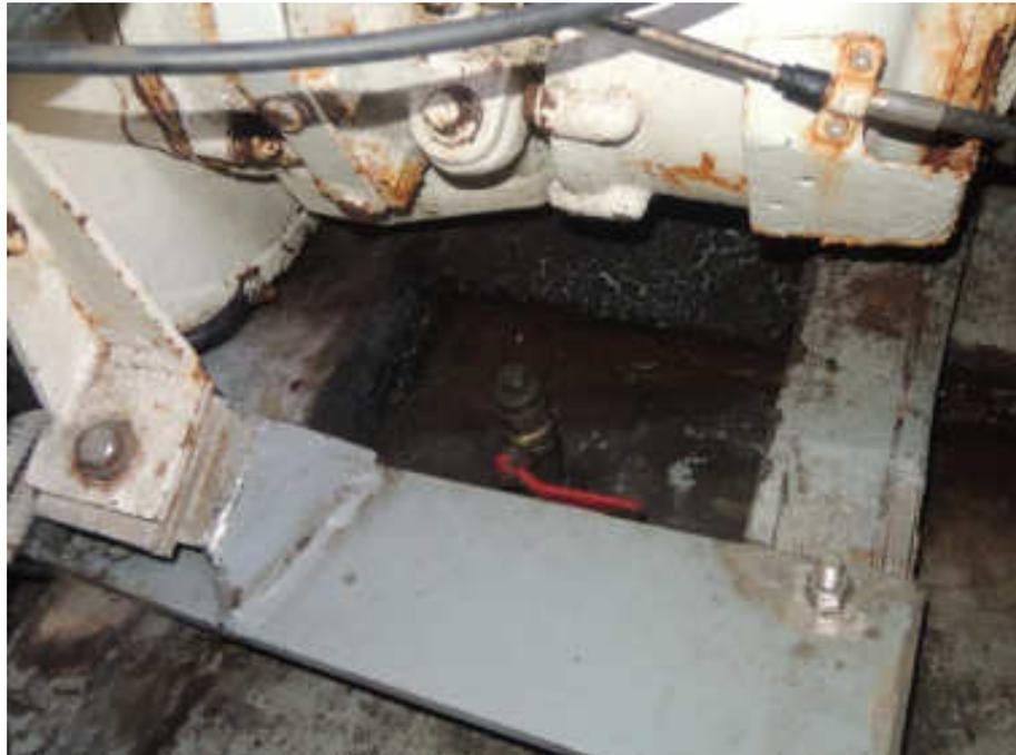
Sulle zone metalliche sono visibili segni di corrosione galvanica.
